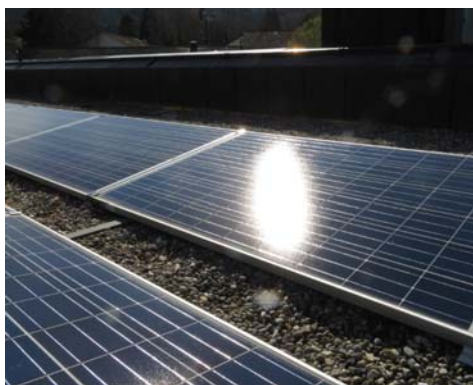
PV Modul mit Blendung, Basler & Hofmann AG
